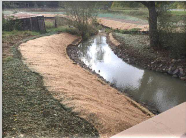
* N. 83 rd Street Reconstruct
